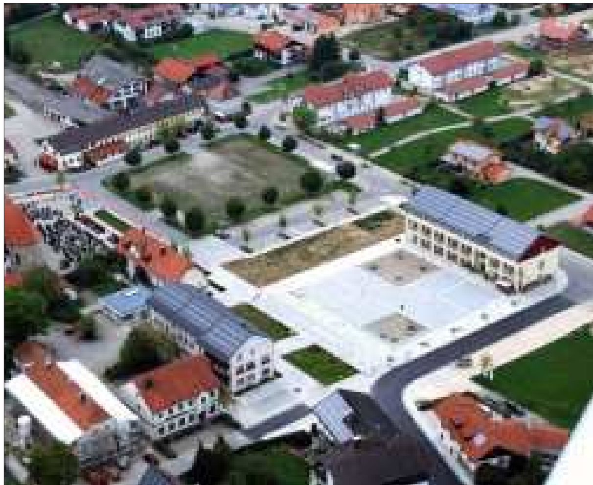
Die neue Dorfmitte, an der im Detail noch gearbeitet wird, wird künftig das Bild Unterneukirchens prägen, wie aus der Vogelperspektive deutlich zu erkennen ist. – Foto: S. Gruber
